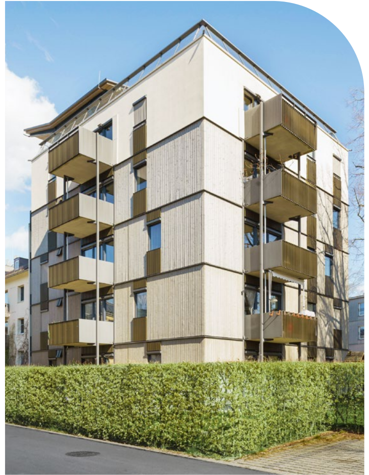
Mit der Autodesk AEC Collection konnte B&O die Qualität der Bauprojekte zusätzlich steigern.
