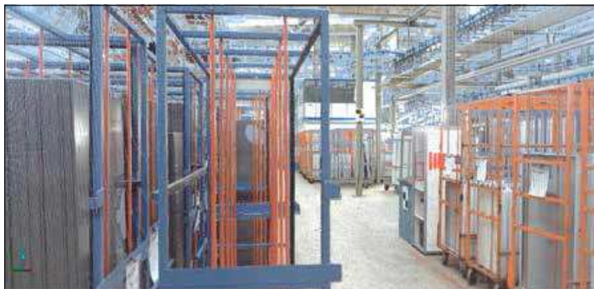
Gescannter Abschnitt der Fabrik. Alle Scans sollen schließlich in ein Gesamtlayout für die ganzheitliche Fabrikplanung einfließen.
